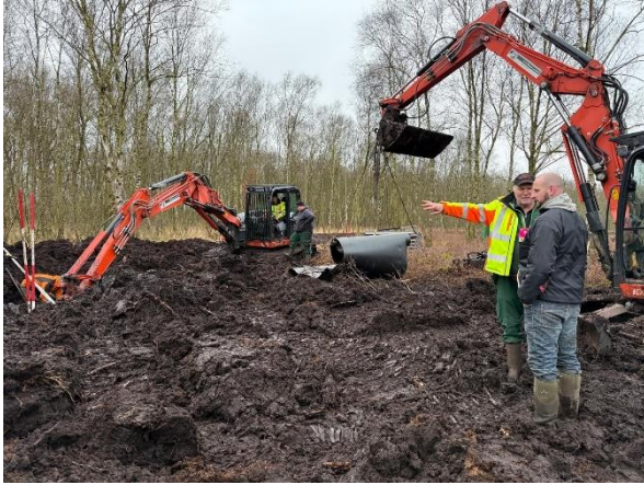
Baubesprechung im Roggendorfer Moor Foto: S. Herzog
