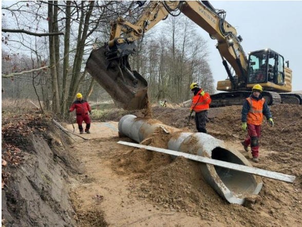
Einbau Durchlass zur Moorrinne Foto: G. Schriefer
