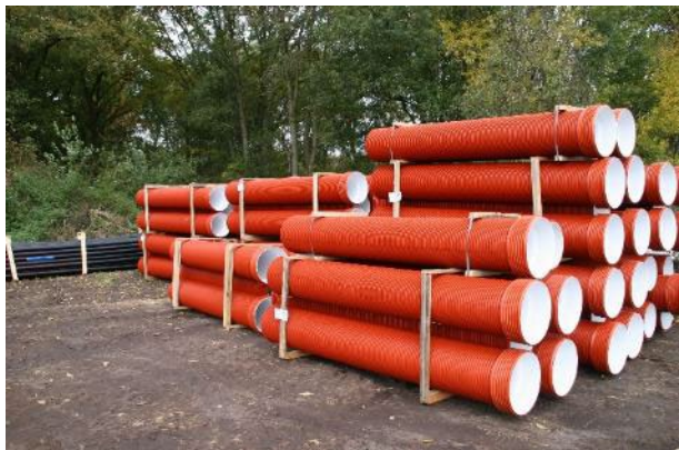
Rohre für Bypass am Neuendorfer Moor Foto: G. Schriefer
