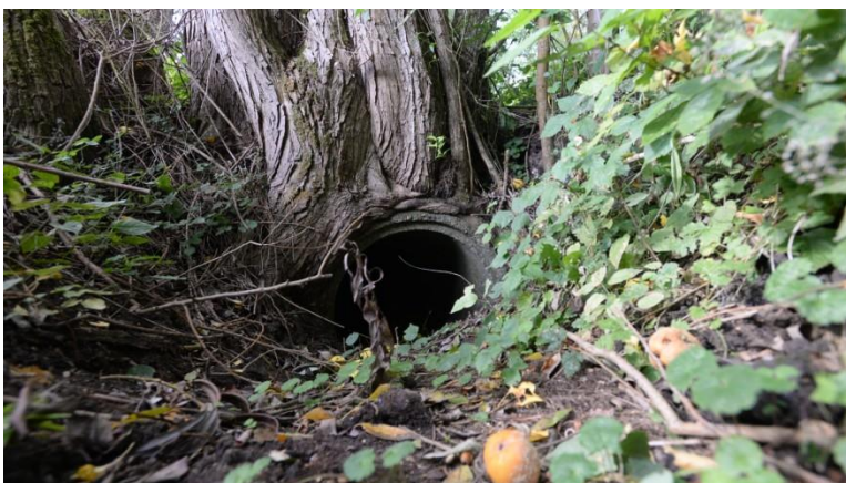
Verrohrter Weitendorfer Bach
